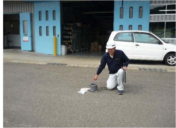
工場出入口①前アスファルト
