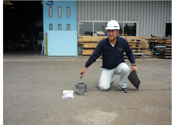
工場出入口③前アスファルト
