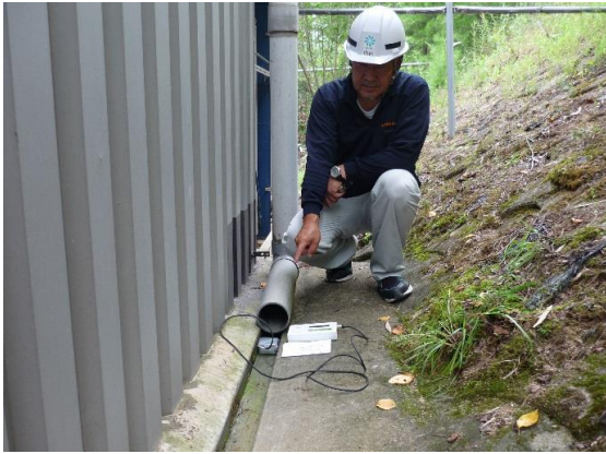
工場の裏㊦雨樋の下
